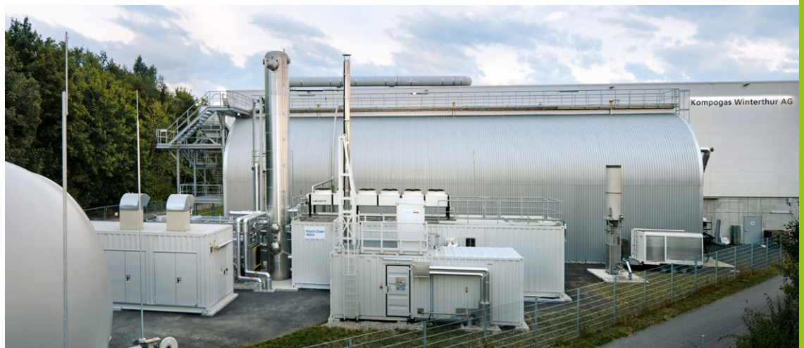
Aufbereitung von Biogas aus Kompogas®-Trockenfermentation mittels Aminwäsche in Winterthur/CH
